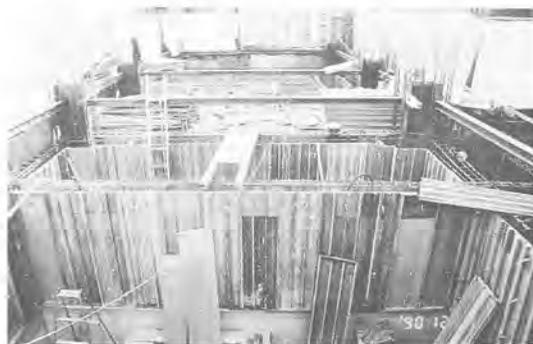
コンクリート型枠として多用されている熱帯材
