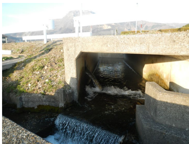
図3.1.3 用水路が排水路に切り替わる落差部
