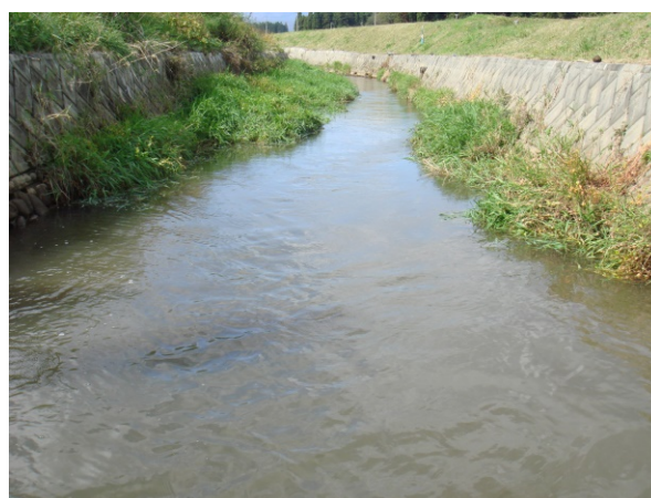
図3.2.3 岩手県奥州市の農業排水路に施工された魚巣ブロック付き2面コンクリート張り護岸水路の直線区間 (a) と屈曲区間 (b)。
