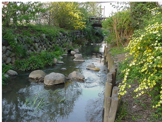
図 3.2.1 東京都日野市の向島用水に施工された空石積み護岸（左側）と木杭護岸（右側）。
