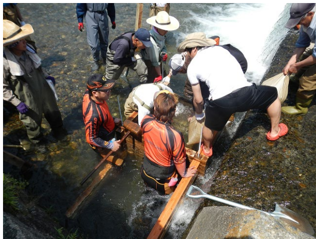
図 3.1.1 鴨川の今井堰に設置中の魚道
