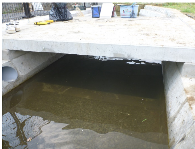
図 3.2.5 東京都多摩市の一ノ宮用水に設置された橋下の魚溜工。
