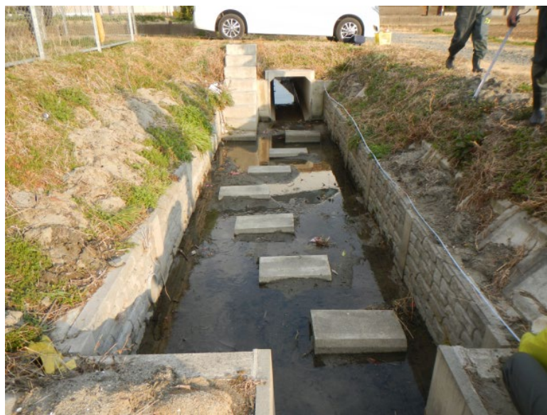
図 3.2.8 三重県松阪市の農業排水路に設置された幅広区間。
