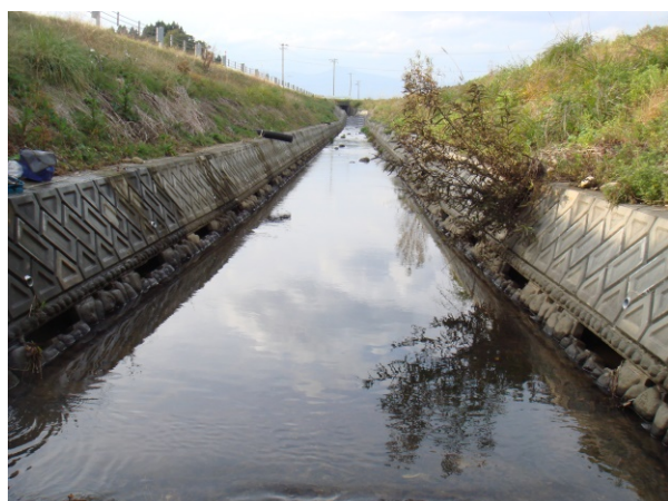
図3.2.3 岩手県奥州市の農業排水路に施工された魚巣ブロック付き2面コンクリート張り護岸水路の直線区間 (a) と屈曲区間 (b)。
