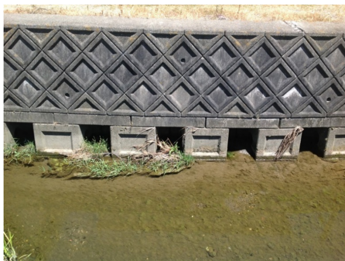
図 3.2.2 彦根市野瀬川水系に設置された魚巣ブロック。空洞型あるいは穴あき型に該当。
