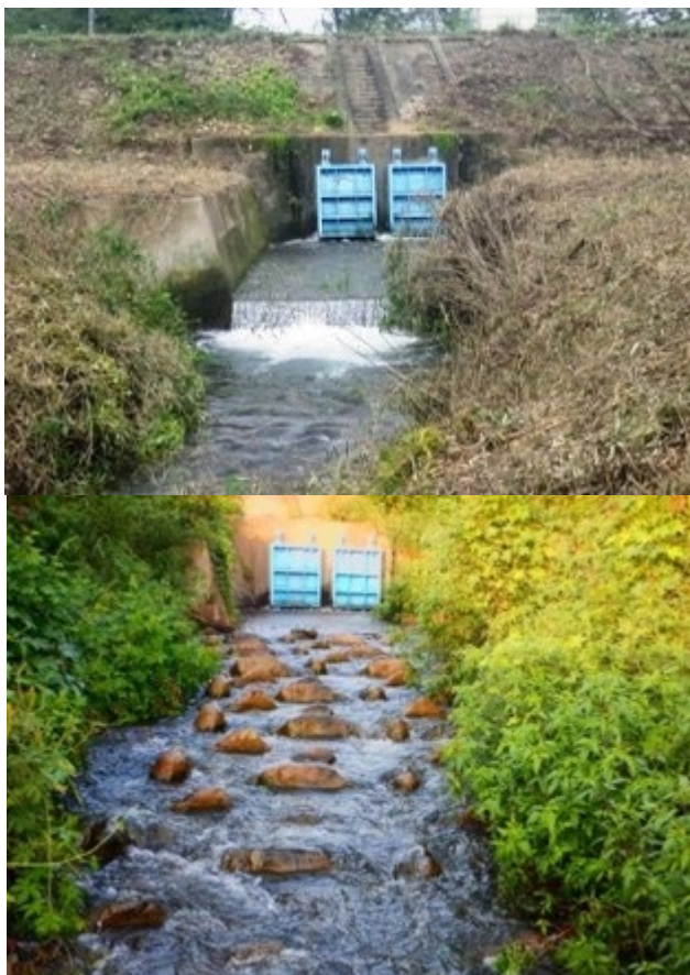
図 3.1.2 生態系ネットワーク再生のための落差解消事例（上：解消前、下：解消後） 写真：岐阜県水産研究所提供
