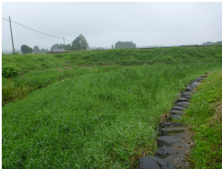
図 3.2.7 屈曲内側に大きな寄洲が形成され、抽水植物が繁茂する様子。
