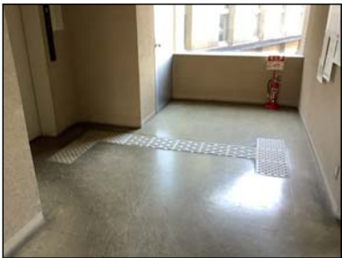
【改修】300角点字（新設）
