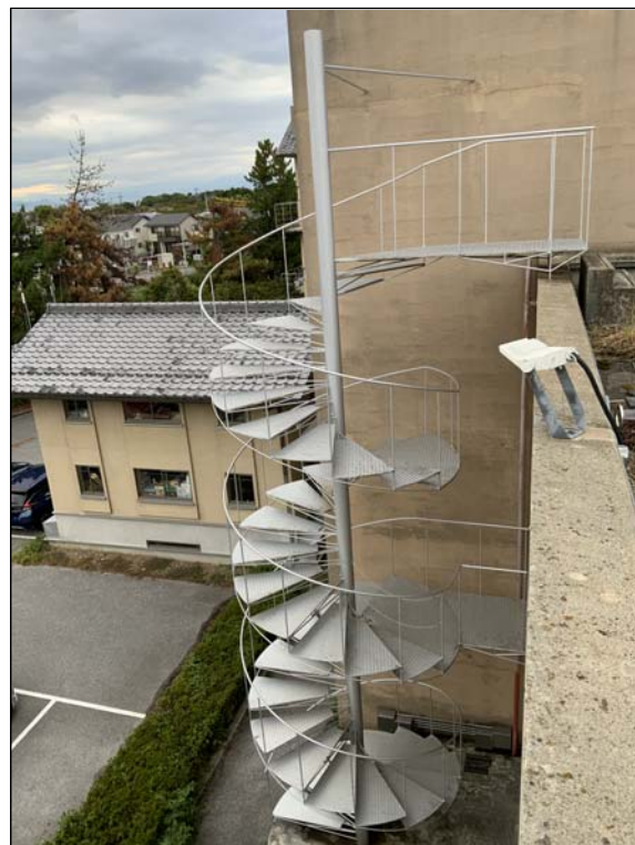
外部階段参考写真
