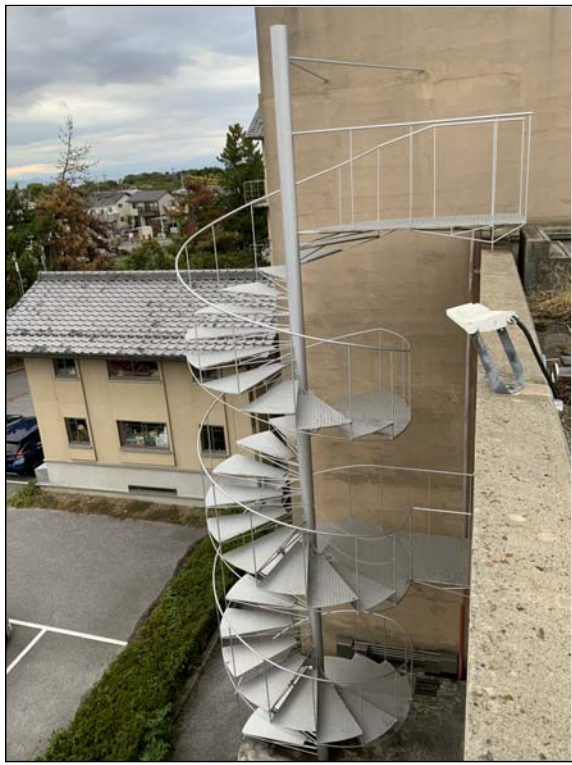
外部階段参考写真
