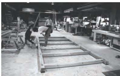
写真：事前の組立風景・まず土台を組み立てます
