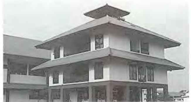
写真3 熱帯型環境共生住宅・外観
