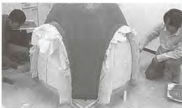
写真6 同 施工の様子
