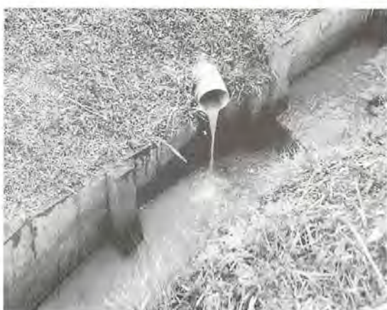
写真2 排水口からの濁水の流出(筆者写す)
