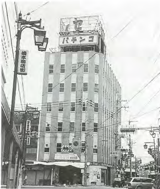
写真1 イセヤビルの外観
